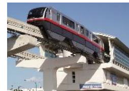
跨座型モノレール・ 車両用電機システム
